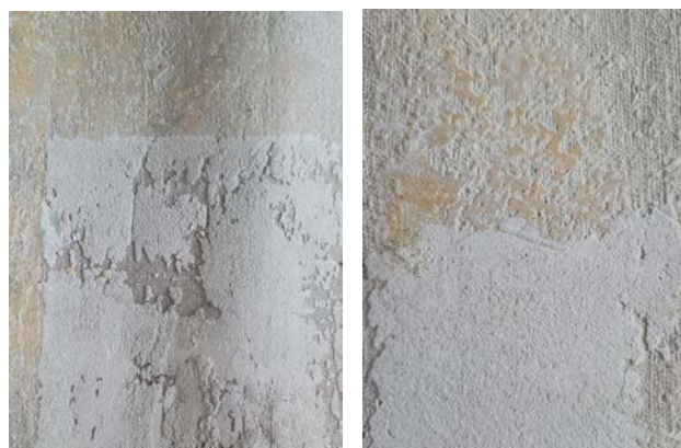
Рис. 5. Поступове зняття тиньку з основи
